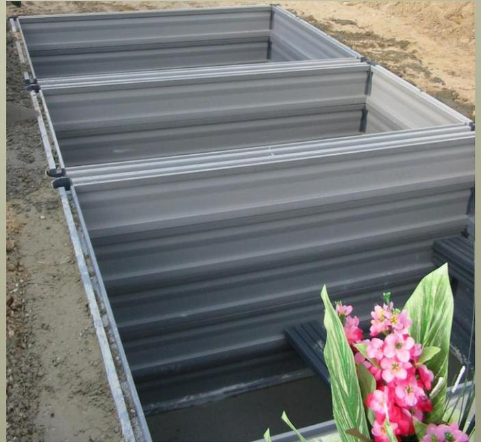
*Mise en place de coffrage perdu pour réalisation de 3 caveaux coulés en places*
