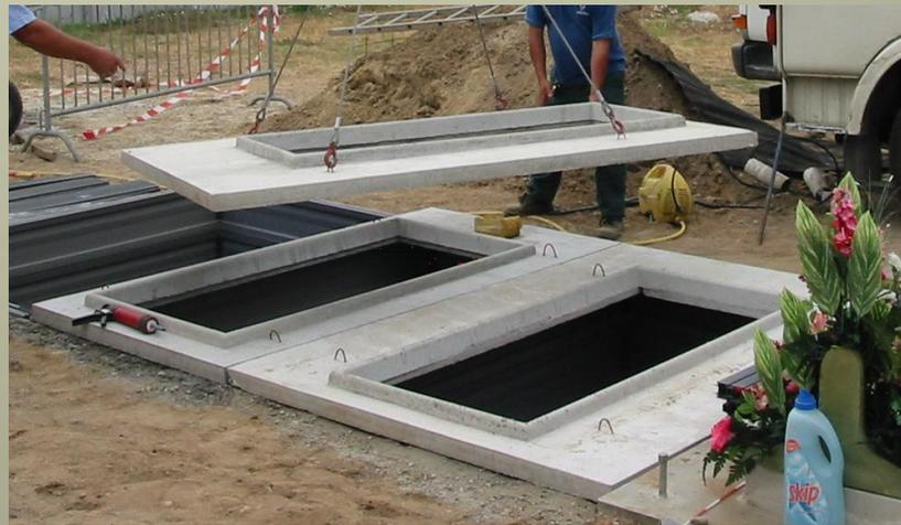
*Terminaison des caveaux par dalle béton*
